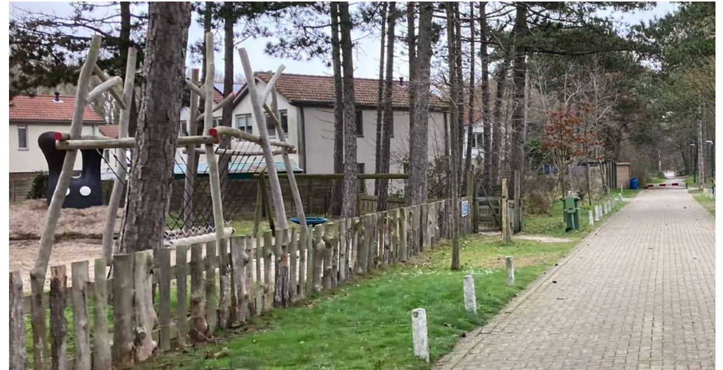
Het speelterrein bestaat uit natuurlijke materialen en wordt omheind door een open, houten constructie
