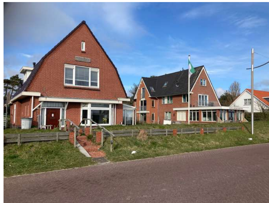
Vrijstaande woningen aan oostzijde, met verhoogde ligging van de woningen
