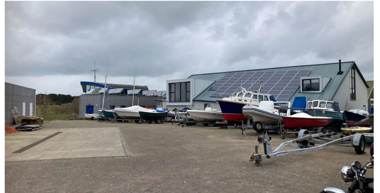
Rechts: installaties staan direct op het dakvlak en volgen dezelfde hellingshoek. Links: zonnepanelen staan onder een andere hellingshoek dan het dakvlak, en volgen hiermee niet de regels en richtlijnen.
