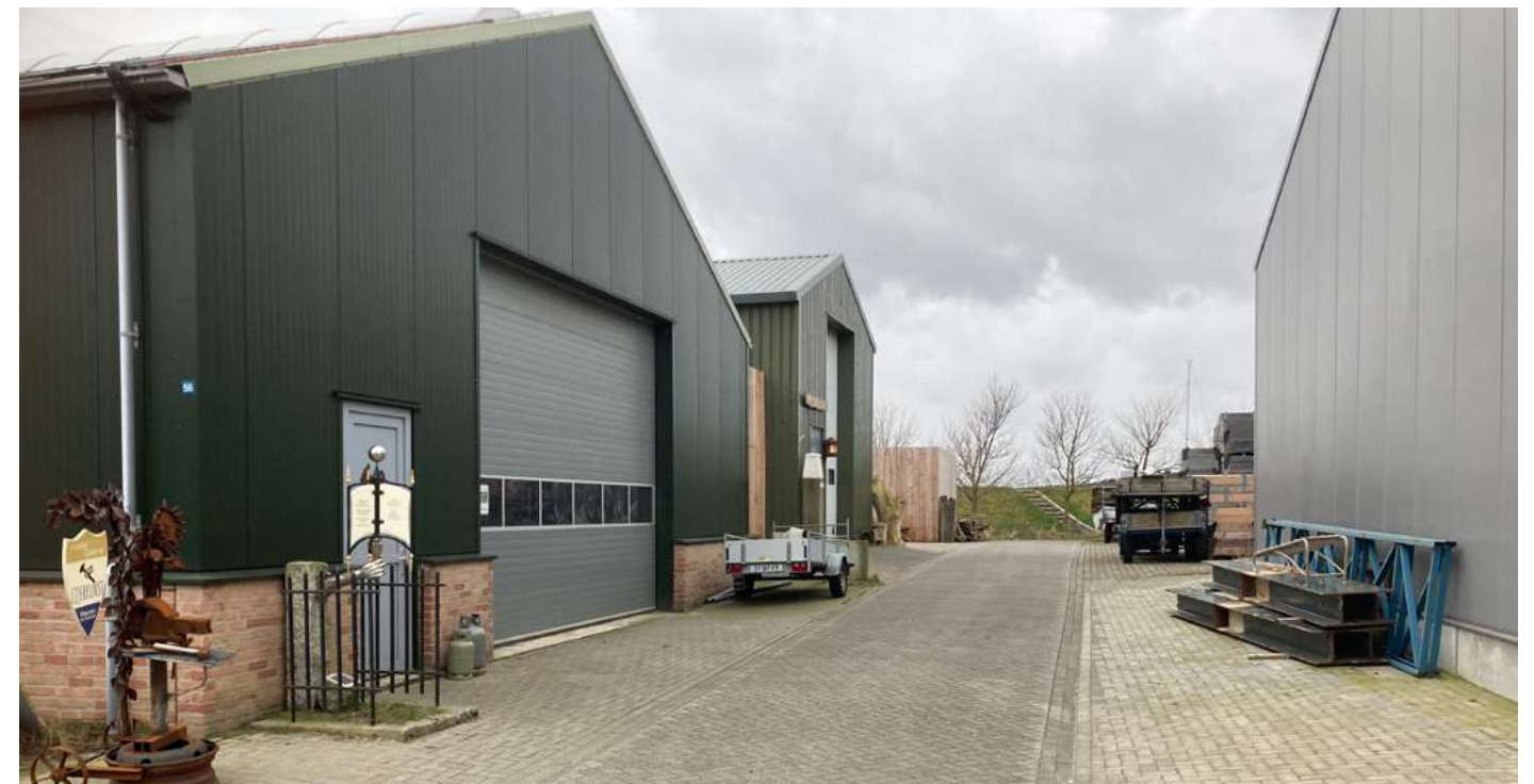
Bedrijfsloodsen met een simpele vormgeving en ingetogen uitstraling.
