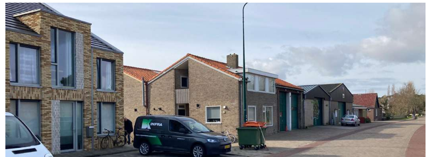
In de huidige situatie is sprake van een stenig karakter en ontbreekt uniformiteit in de bebouwing
