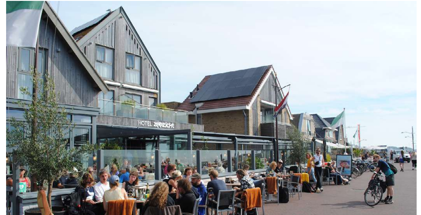
Installaties zoals zonnepanelen staan direct op het dakvlak en volgen dezelfde hellingshoek
