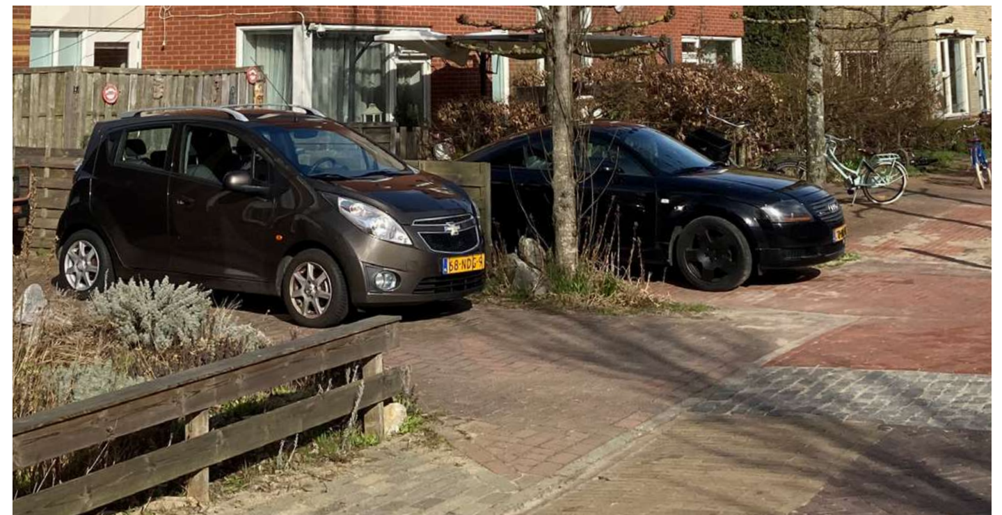
Oprit met waterdoorlaatbare bestrating
