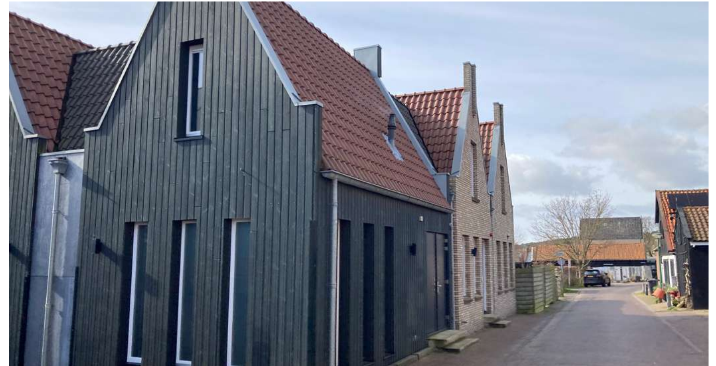
Gevelmateriaal bestaat uit bakstenen, of hout en de daken zijn bedekt met rode dakpannen
