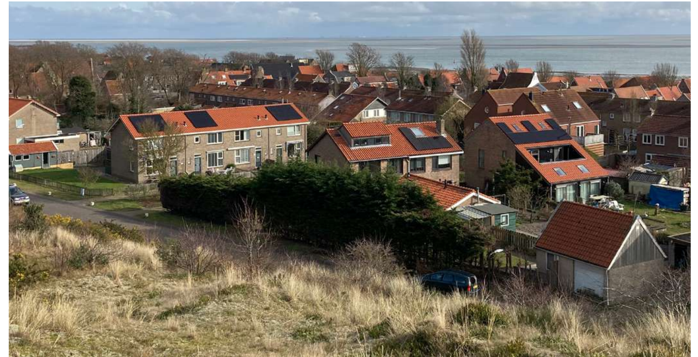
Installaties staan direct op het dakvlak en volgen dezelfde hellingshoek
