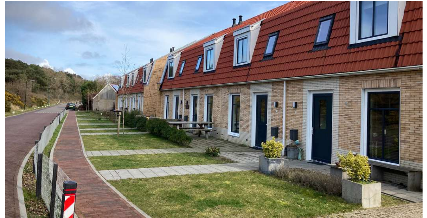
Bescheiden vormgegeven toegangspaden
